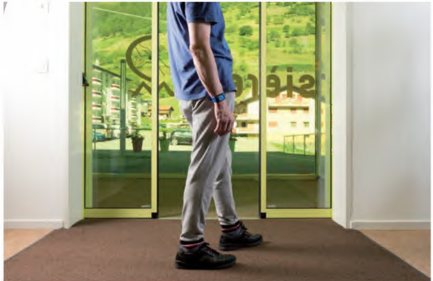
Le nouveau système anti-errance permet notamment de verrouiller la porte d'entrée principale pour prévenir tout risque de fugue chez certains résidents.
